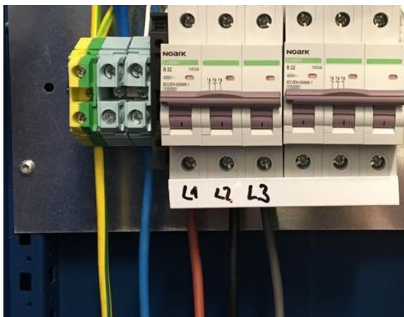
Obrázek 6: Zapojení vodičů v TN-S síti
