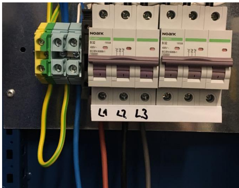
Obrázek 5: Zapojení vodičů v TN-C síti
